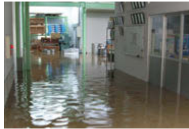
集中豪雨で浸水した内子工場(2005.7)
