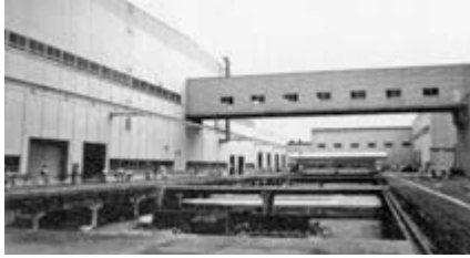
スーパージョイントが 使用されている新幹線 利府基地
