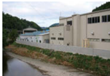
内子工場の水害防止用外壁完成(2005)
